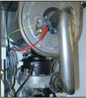
Fig. 16 Per lo smontaggio del bruciatore togliere l'alimentazione elettrica ed i collegamenti al ventilatore
