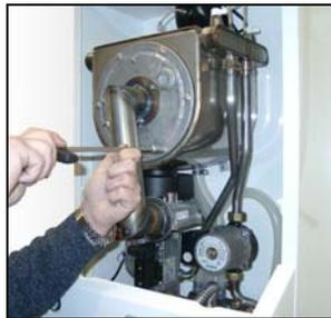
Fig. 17 Smontaggio della flangia del bruciatore
